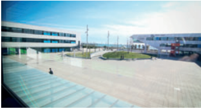
Instal·lacions del Tecnocampus.
